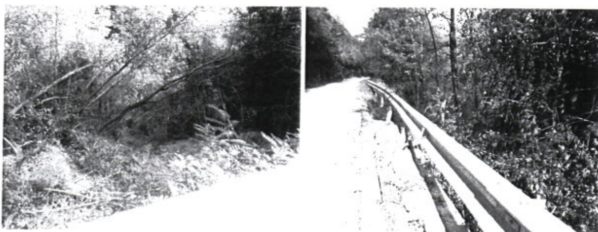
Глетчеобразно свличане под пътното платно Деформации по мантизелата и бордюра 13.09.2017.
